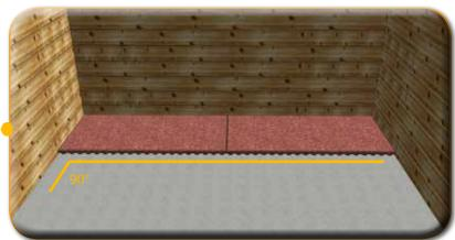
Installare la seconda fila sfalsata rispetto alla prima di mezza piastra. Proseguire sfalsando le altre file a completamento della superficie
