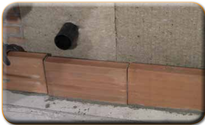
Iniziare a relizzare la parete Start to built the wall
