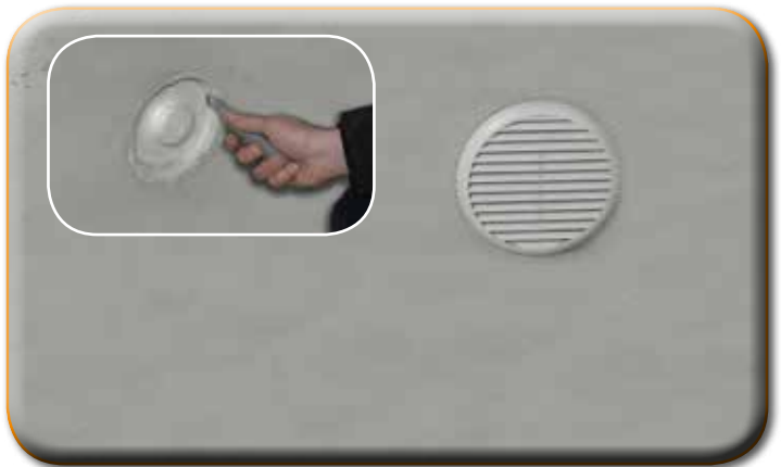
Tagliare o togliere il tappo del Sylencer e inserire la griglia di finitura Cut or remove the cap and insert the grid in the hole of the Sylencer
