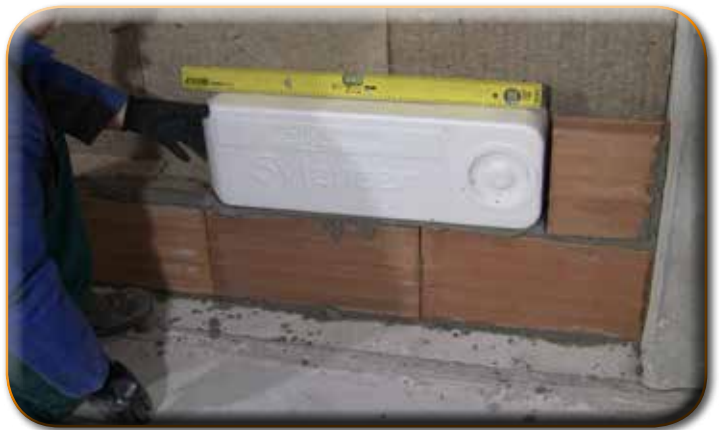
Posare il Sylencer sul letto di malta Lay the Sylencer on mortar
