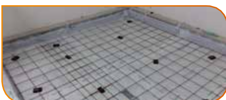
Applicare un telo protettivo e posare la rete di rinforzo distanziata di circa 2 cm Place a protection film and lay the reinforcement mesh at the approximate height of 2 cm
