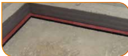
Posare le strisce Side Highmat su tutto il perimetro a ridosso della fascia Profyle Place the Side Highmat bearings along the whole perimeter next to the Profyle
